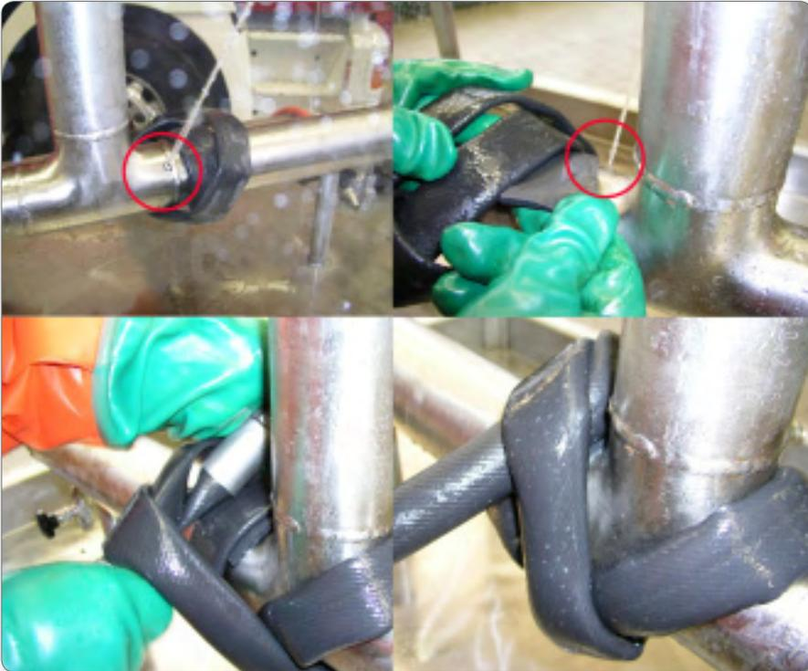
Система высоко давления для ликвидации течей Vetter состоит из одного или трех уплотняющих шлангов (в зависимости от модели). Они применяются для ликвидации течей в T-образных соединениях, в местах изгибов труб или для изоляции проблемных соединений.
